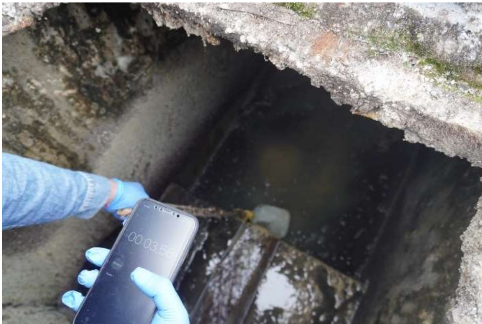
Figura 15: Medición del caudal a la entrada de la PTAR. Fuente: Mauricio Alejandro Molina Nogales
