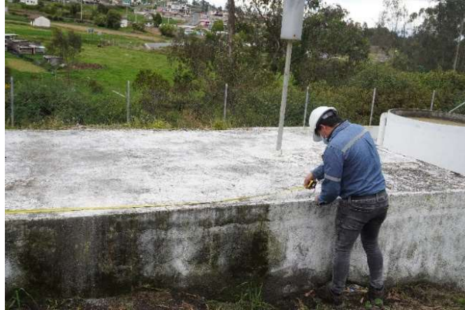
Figura 9: Medición del tanque séptico Fuente: El Autor
