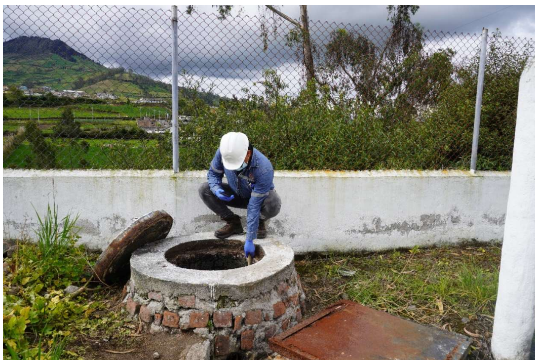
Figura 34. Medición de Caudal de salida a la PTAR
