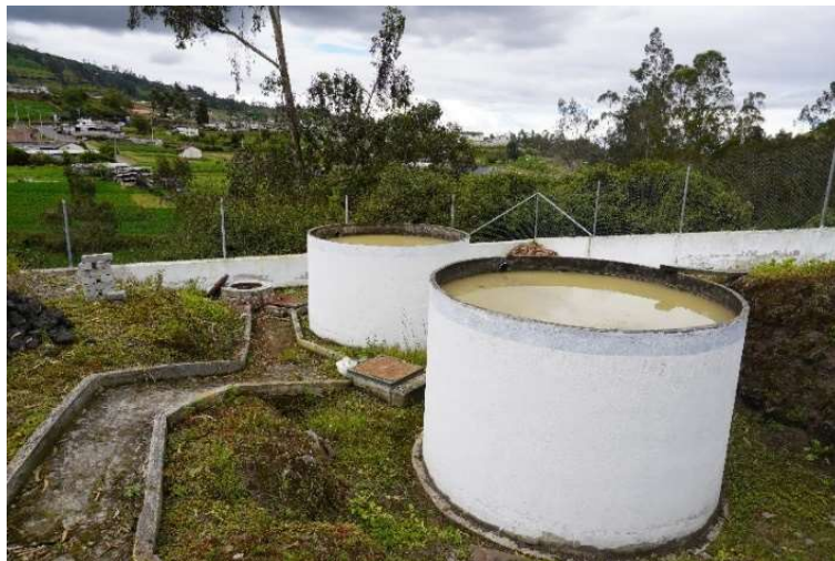
Figura 10: Filtro anaerobio de flujo ascendente. Fuente: El Autor
