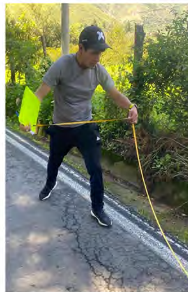
FOTOGRAFÍA 4.- Medición de fallas durante la inspección PCI.
