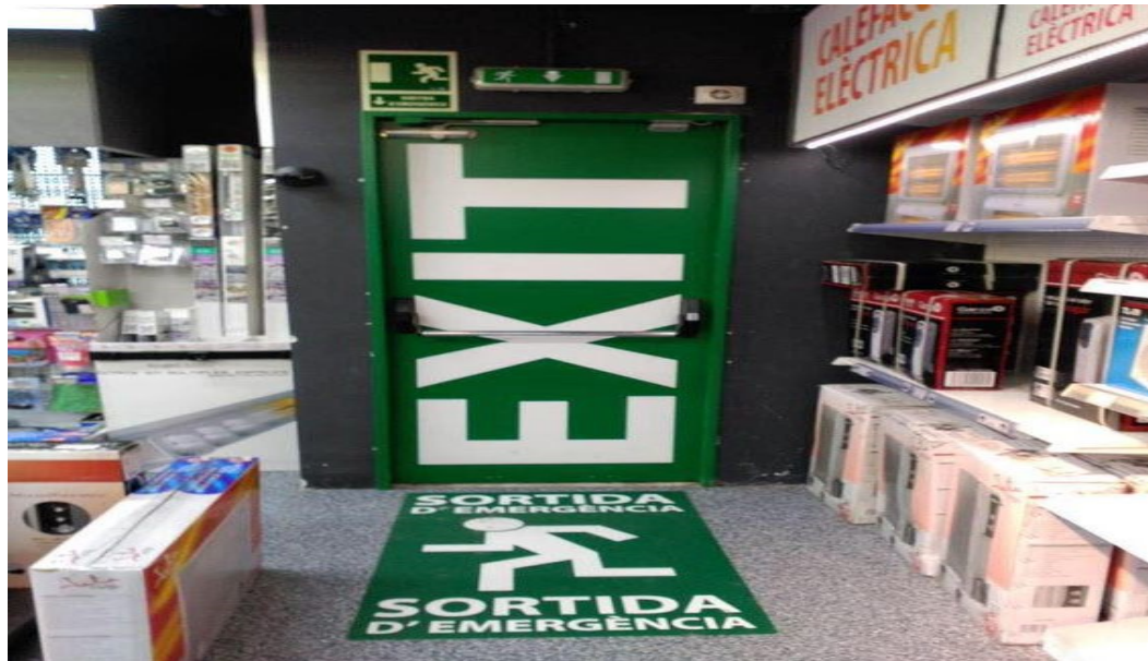
Ilustración 29: Salidas De Emergencia
