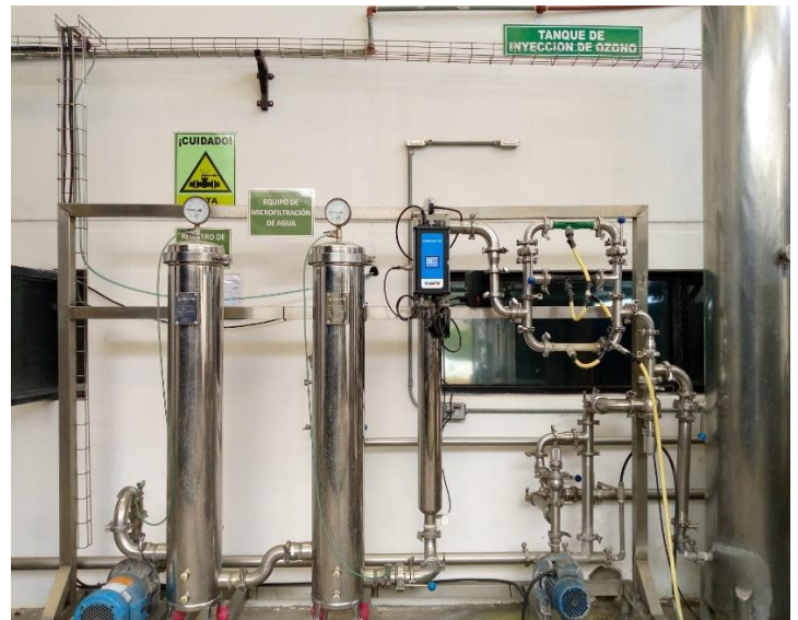
Sistema de sanitización de agua
