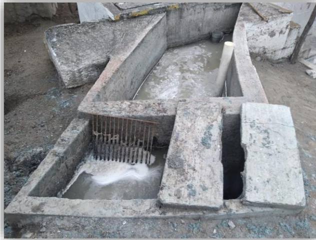
Figura 5: Cámara de entrada
