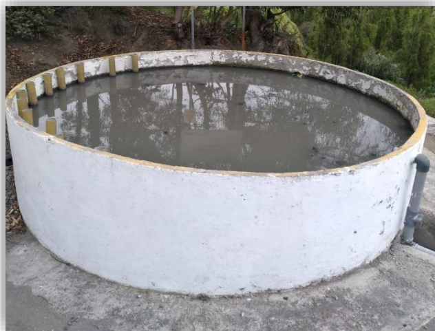
Figura 8: Filtro anaerobio de flujo ascendente (FAFA)
