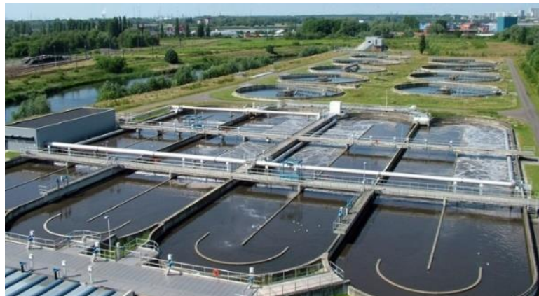
Figura 1: Planta de tratamiento de aguas residuales
