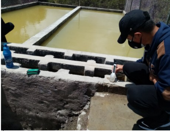
Quebrada de Tiliche captación reservorio
