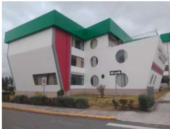
Fotografía N.ª 5 Medición de la altura de la losa
