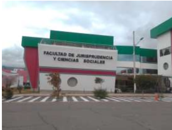
Fotografía N.º 2 Vista Posterior del edificio a evaluar
