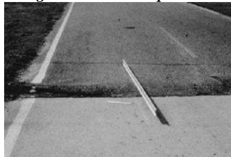
Imagen N° 7: Fisura parabólica
