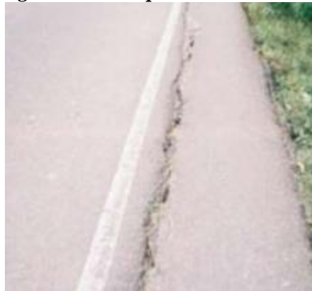
Imagen N° 22: Separación de la berma
