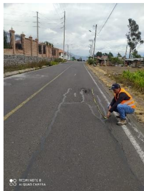
Identificación y medición de la falla
