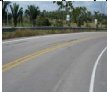
Imagen N° 19: Desgaste superficial
