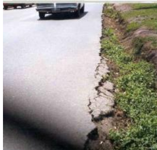
Imagen N° 17: Desintegración de bordes
