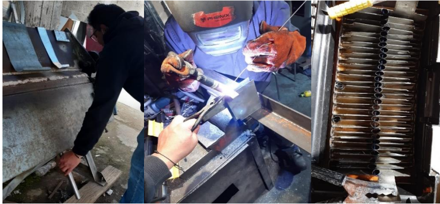
Figura 49: Elaboración de placas y soldadura
