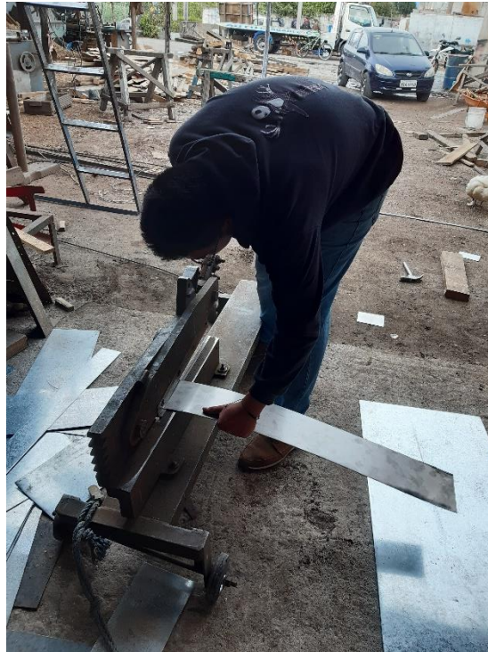
Figura 42: Corte de celdas de acero Inox AISI 304.
