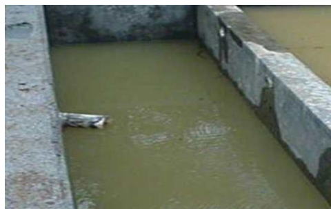
Figura 16: Desarenador (PTAR).
