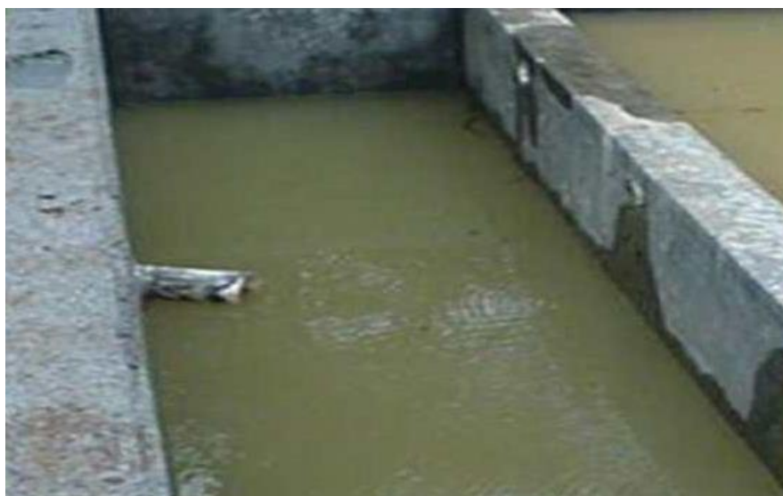
Figura 41: Desarenador (PTAR).
