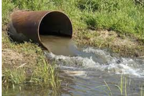
Figura 1: Agua residual doméstica
