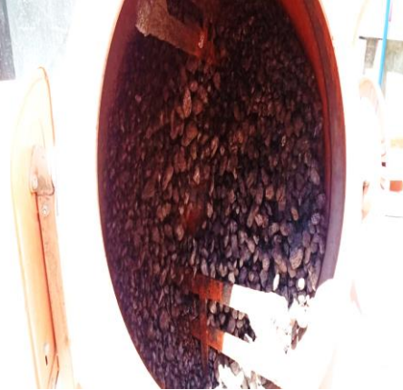
Fotografía 45.- Mezcla de Materiales en concretera.
