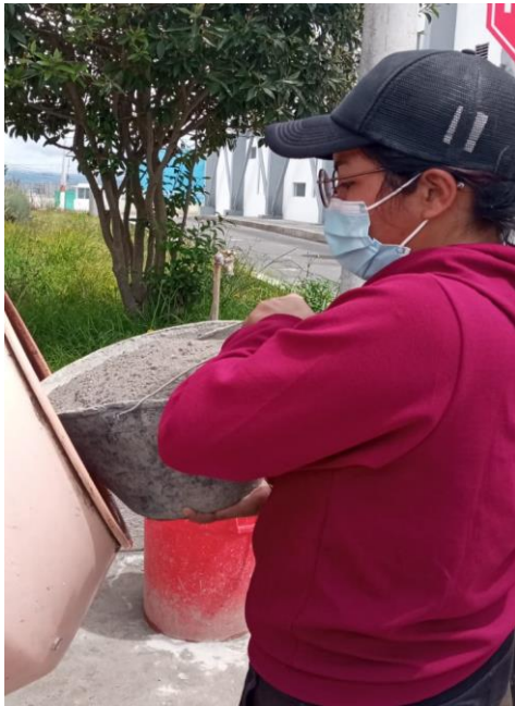
Fotografía 31.- Incorporación de agregado fino a la mezcla.
