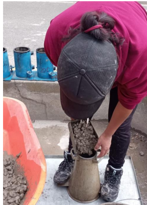
Fotografía 46.- Vertido de hormigón ligero fresco en el cono en capas.
