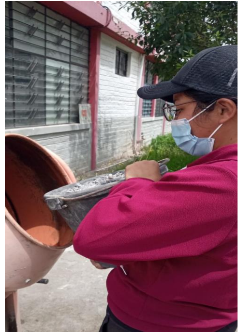
Fotografía 30.- Incorporación de agregado grueso a la mezcla.
