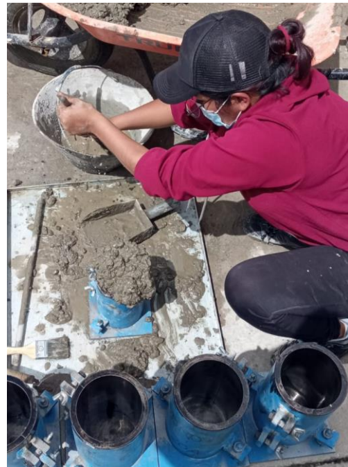
Fotografía 52.- Limpieza de varilla para enrasar espécimen de hormigón fresco.
