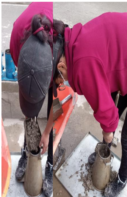
Fotografía 47.- Prueba de asentamiento por el Cono de Abrams- Vertido en capas y compactación por varillado.
