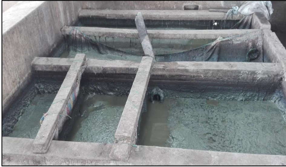
Figura 27. Lonas para retener los efluentes sólidos.
