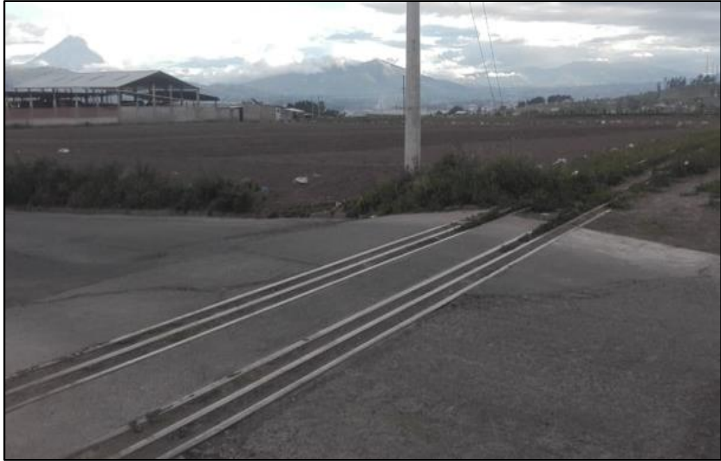
Figura 44. Líneas férreas. Fuente: El investigador.
