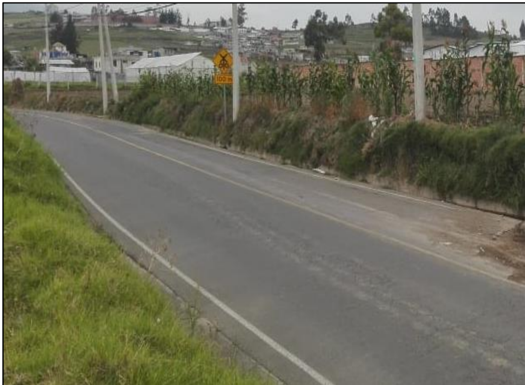
Figura 37. Vía de primer orden. Fuente: Curtiembre Martínez.
