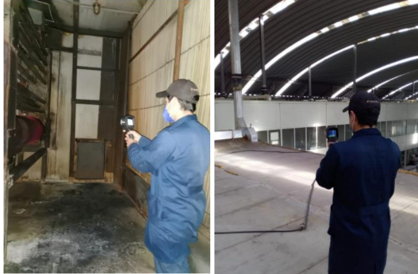
Figura 20. Toma de datos de temperatura en intercambiadores de calor.
