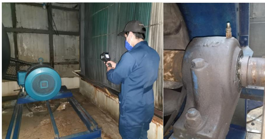
Figura 21. Toma de datos en equipos eléctricos y mecánicos.
