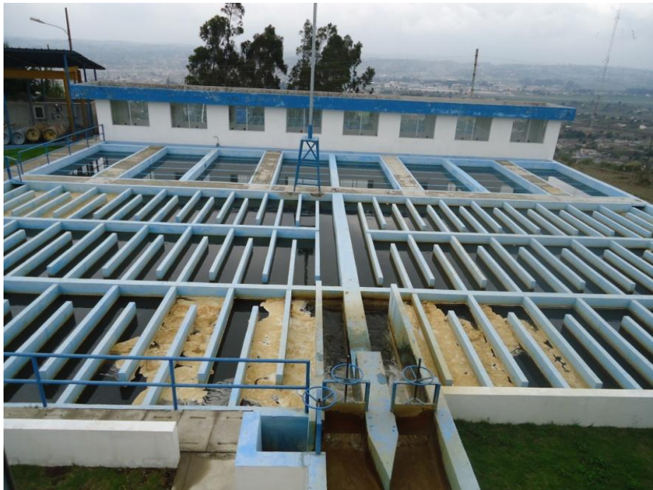
Figura 8. Locación Productora Loma de Alcoceres Fuente: [34]
