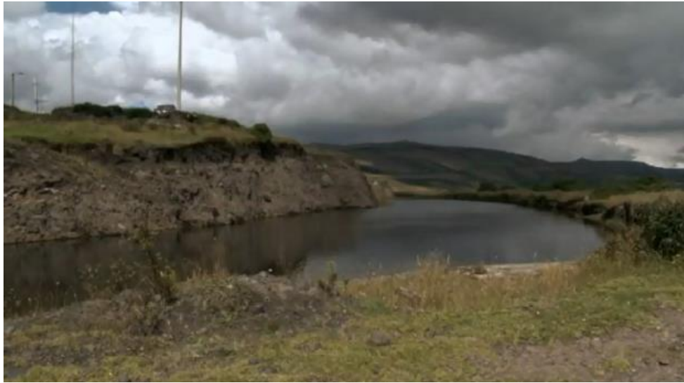
Figura 7. Fuente superficial Laguna Salayambo Fuente: [34]
