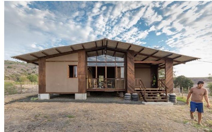
Imagen 8 Vivienda Post terremoto Por: Arq. Al borde
