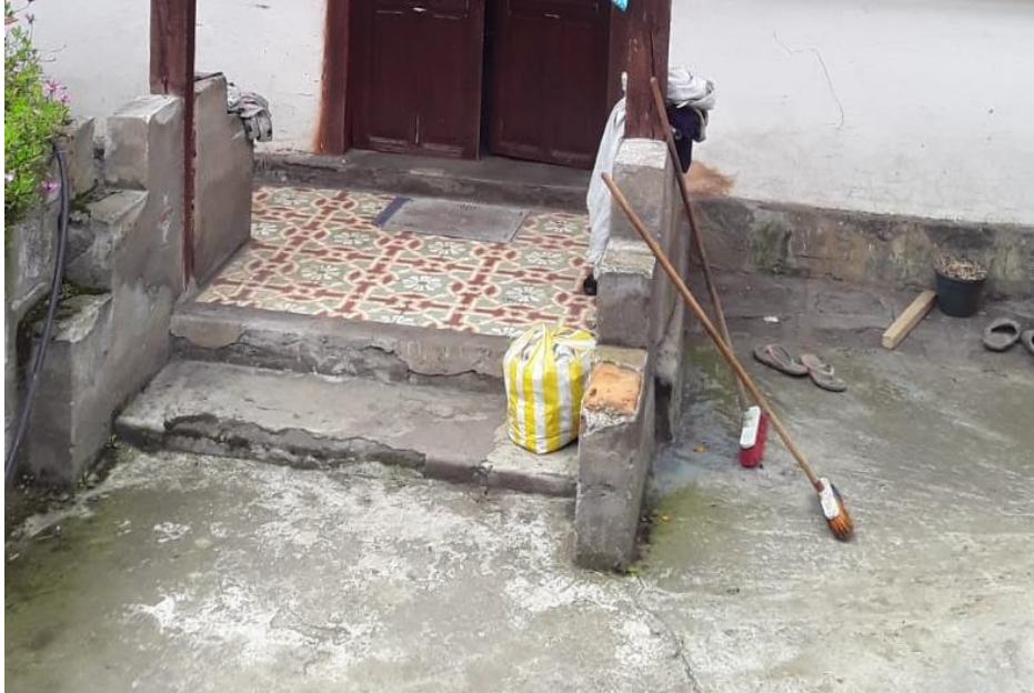
Imagen 16. Tipos de piso en una vivienda. (Fuente: Daniel Peñafiel Valla)
