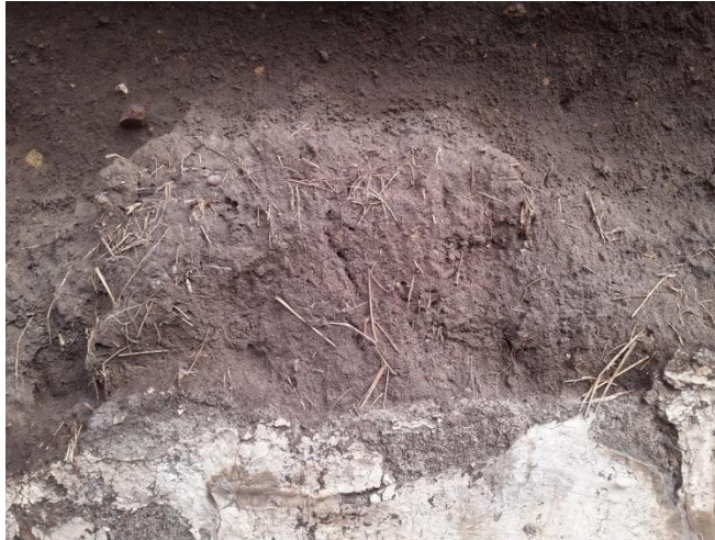
Imagen 29. Detalle enlucido con cal, fibra de paja y agua. (Fuente: Daniel Peñafiel Valla)
