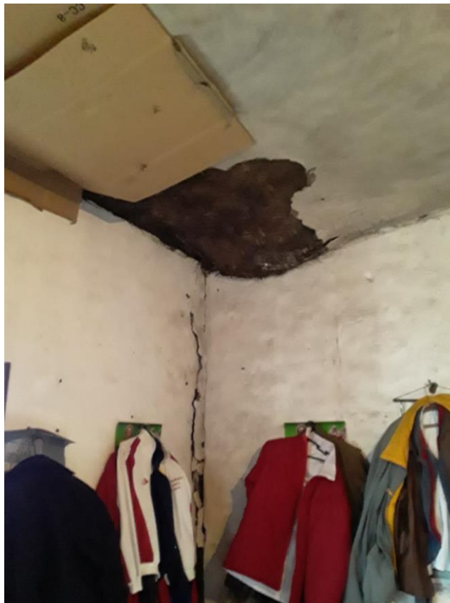
Imagen 30. Detalle aislamiento del cielo falso con mortero de cal y estero. (Fuente: Daniel Peñafiel Valla)
