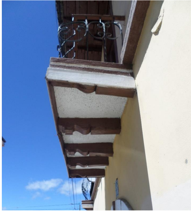
Imagen 20. Soporte estructural, balcón. (Fuente: Daniel Peñafiel Valla)
