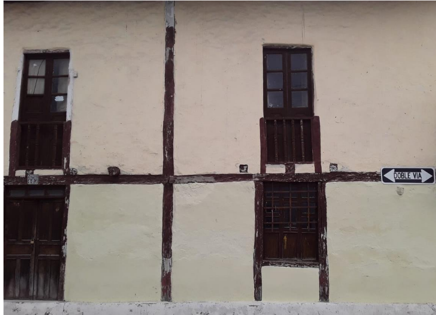
Imagen 11. Vigas de madera estructurales, Vivienda patrimonial, Tisaleo. (Fuente: Daniel Peñafiel Valla)
