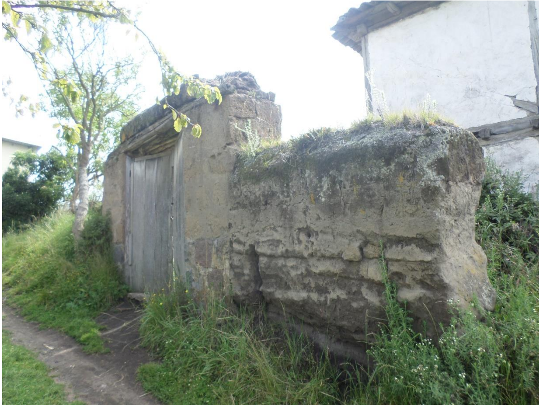
Imagen 22. Detalle pared de tapiá. (Fuente: Daniel Peñafiel Valla)
