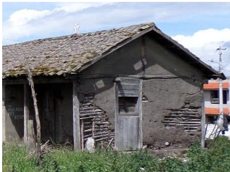
Imagen 13. Detalle del muro del siglo XX de la vivienda tradicional, compuesto por bahareque, adobe, piedra y madera. (Fuente: Daniel Peñafiel Valla)
