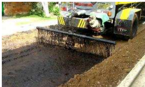
Figura 8: Estabilización con asfalto.
