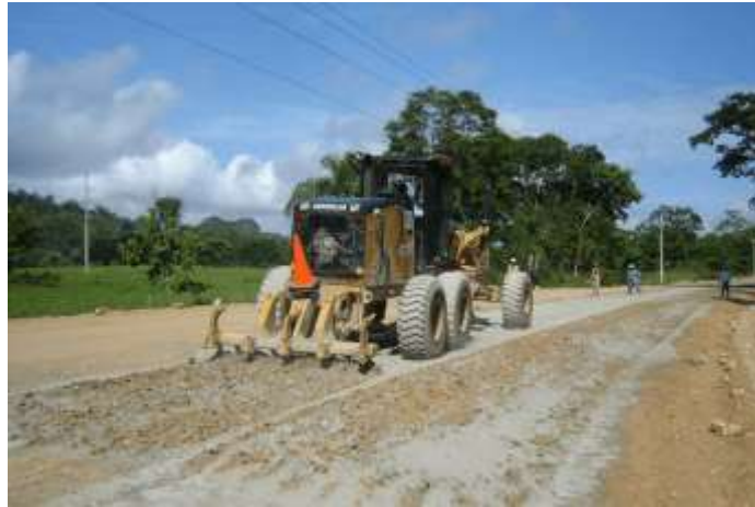
Figura 4: Estabilización de suelos por medios químicos
