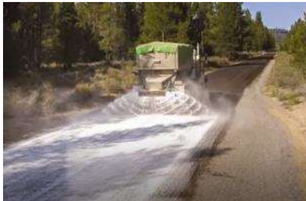
Figura 6: Estabilización con Cloruro de Sodio
