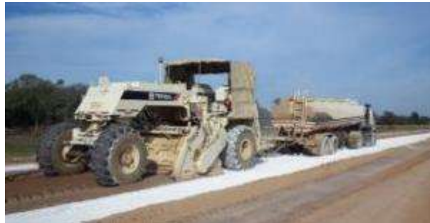
Figura 7: Estabilización con cal.
