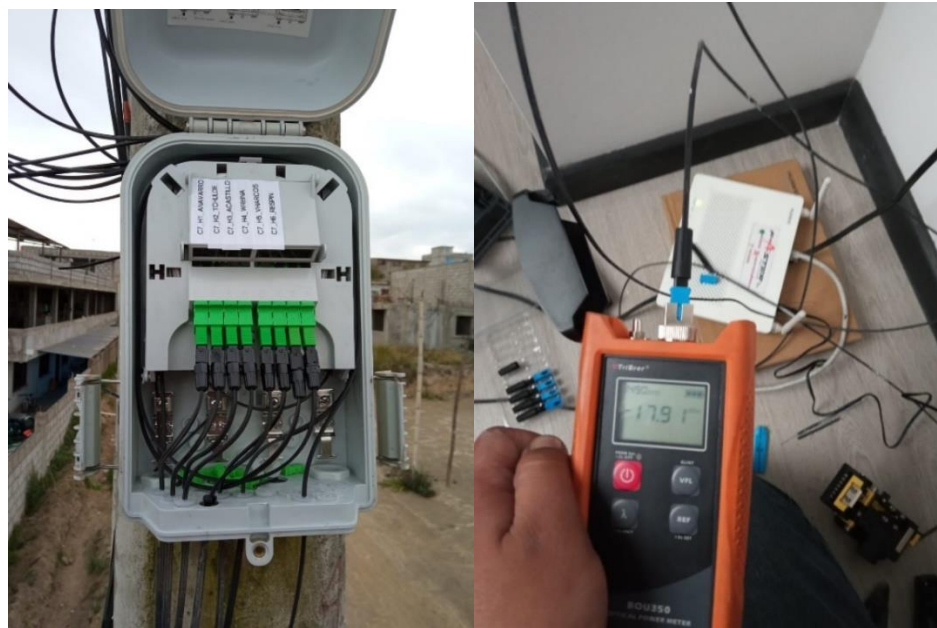
Figura 4.25 Instalación última milla y prueba de potencia óptica
