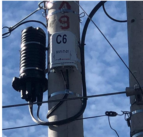
Figura 4.2 NAP aérea red de distribución FASTER-ISP
