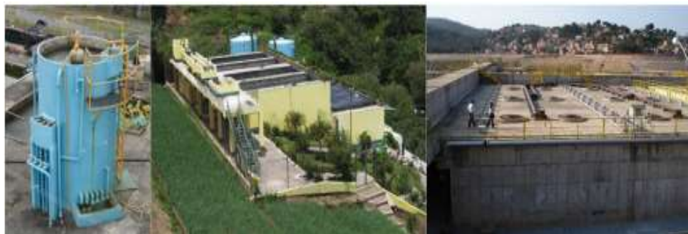
Fig. 10 Ejemplos de Reactores Anaerobios de Flujo Ascendente a escala real para diferentes rangos de población (Oakley, 2017).
