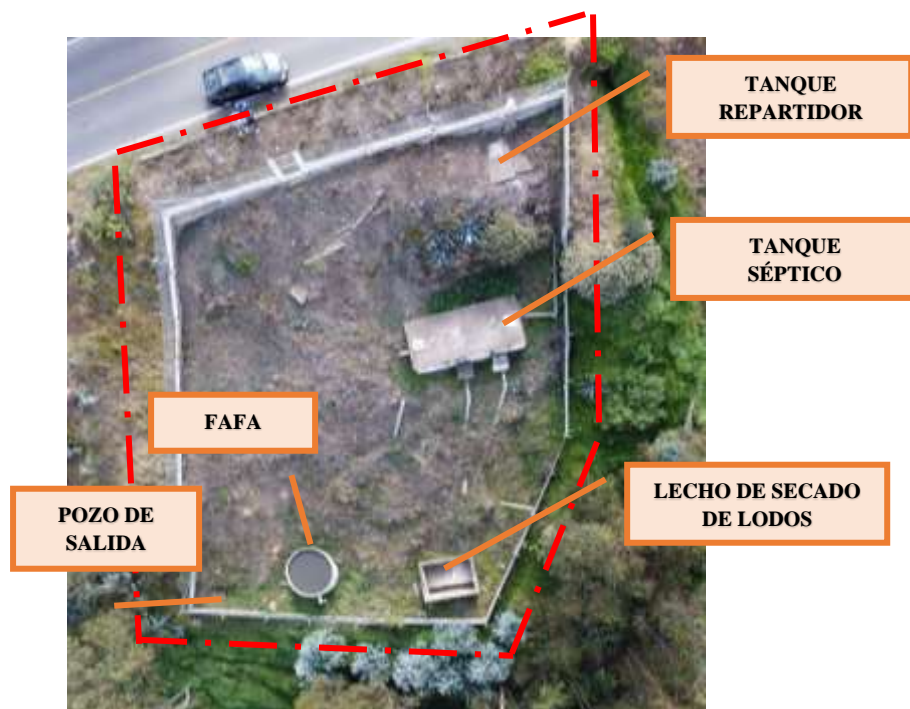
Figura 8 PTAR Limpe Grande – Quero.
