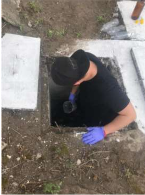
Figura 9 Medición de caudales al ingreso de la planta de tratamiento.
