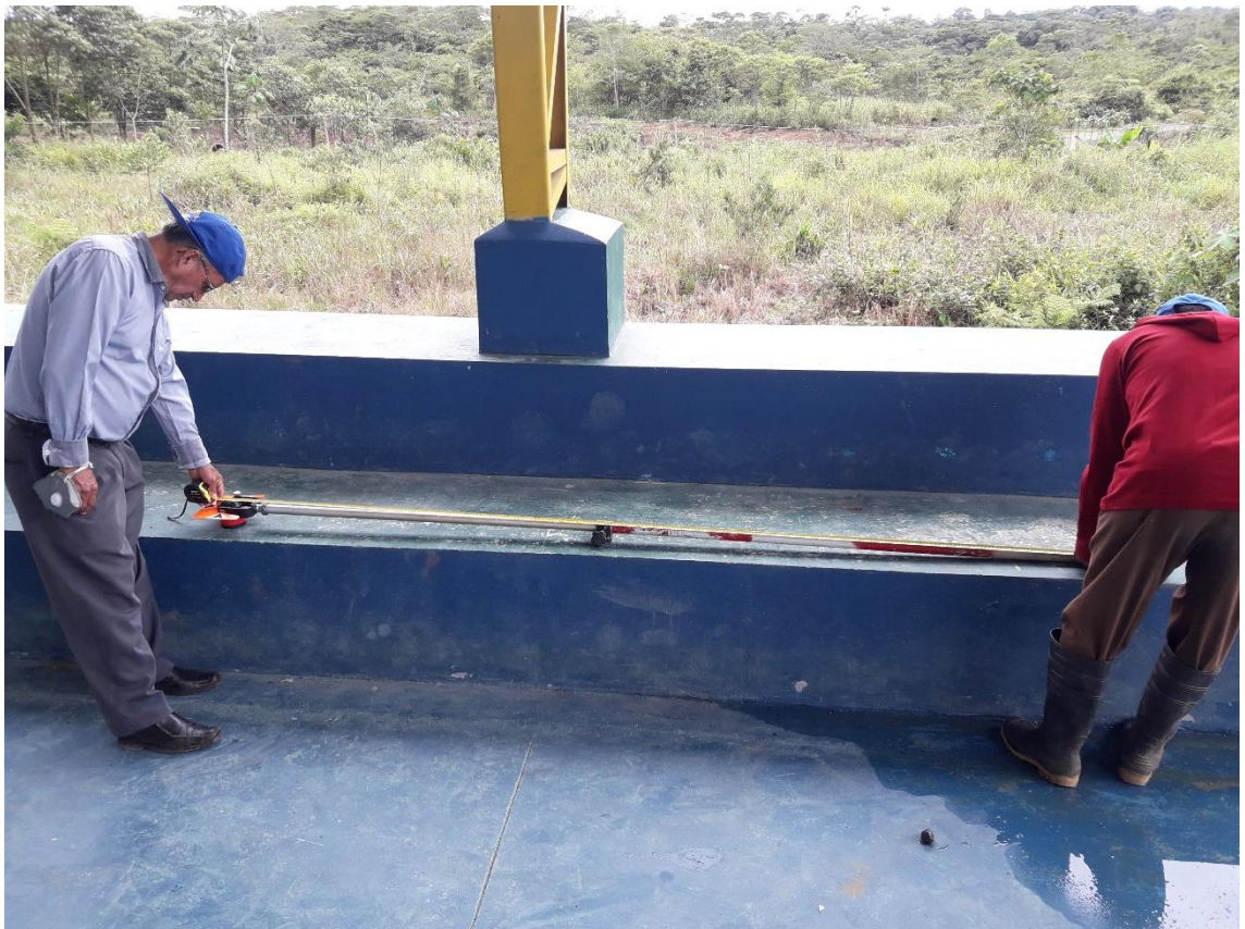
Medición de equipos topográficos
