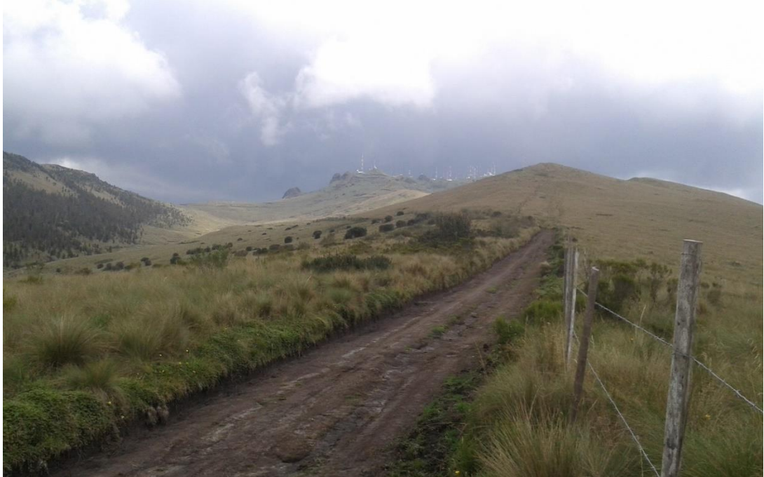
Gráfico 22: Estado actual de la vía al cerro Pilisurco
