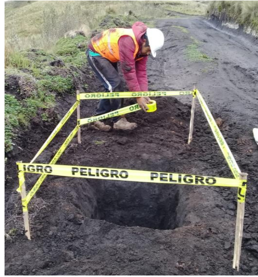
Limitación de la calicata con el fin evitar accidentes
