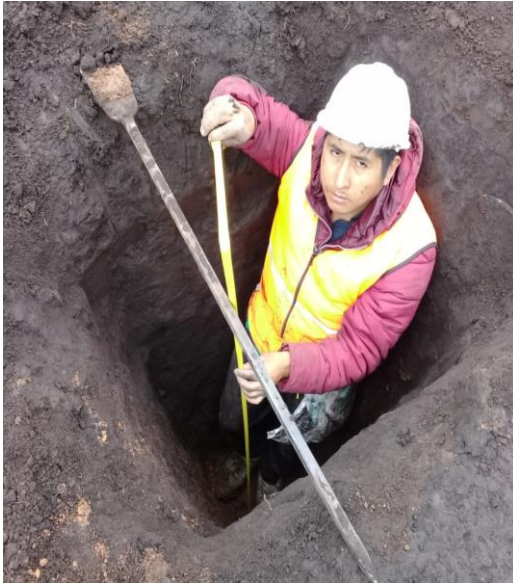
Midiendo profundidad de calicata.
