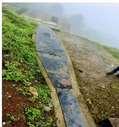
**Figura 14:** Desarenador (PTAR).
