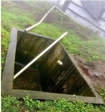
**Figura 17:** Lecho de secado de lodos (PTAR).
