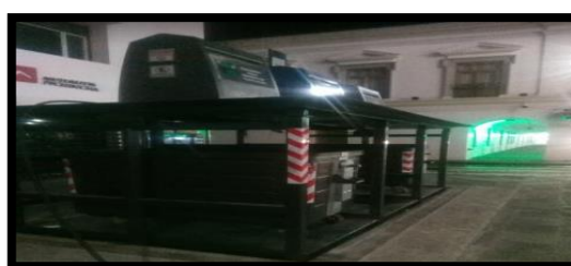
Figura 8. Contenedores de las islas soterrados
