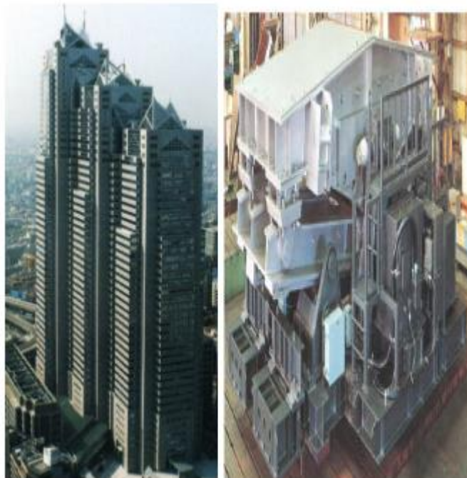
Fig. 12 Torre Shinjuku (Japón) con sistema de control semi-activo
