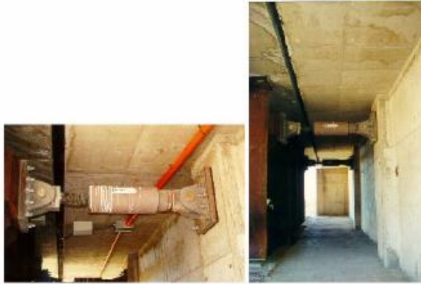
Fig. 21 Amortiguador Viscoelástico
