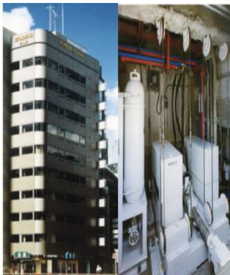
Fig. 10 Edificio Kyobashi Seiwa (Japón) con sistema de control activo
