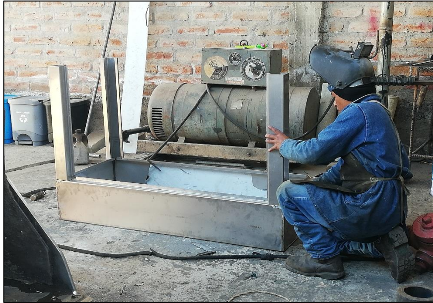
Figura B.1: Soldadura pilares. Elaborado por: El investigador.
