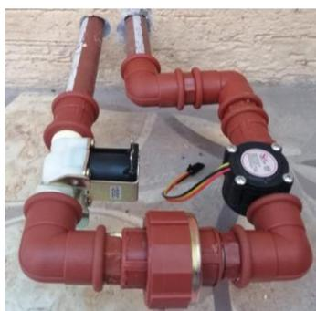
**Figura 19:** Conexión de electroválvula y sensor de flujo
