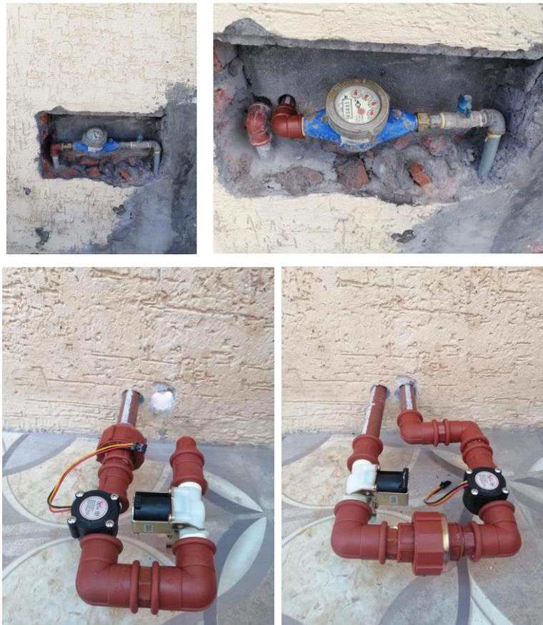
**Figura 50:** Instalación de electroválvula y sensor de flujo
