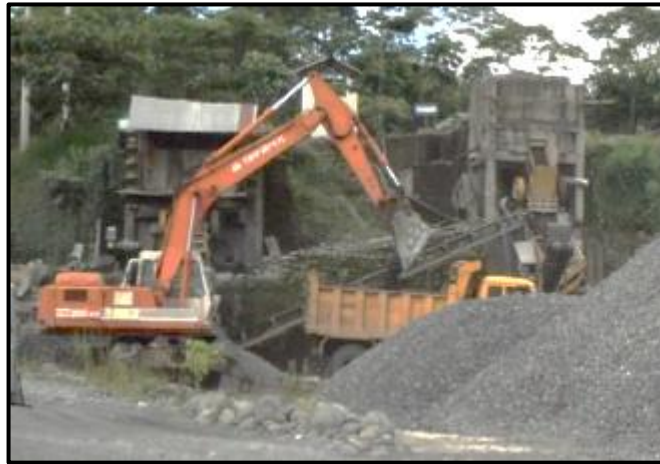
Imagen 12. Zarandeo de los agregados pétreos
