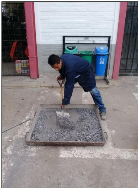
Fotografía 23. Mezcla de los agregados
