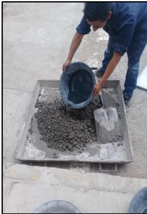
Fotografía 59. Adición de silicato de sodio en la mezcla
