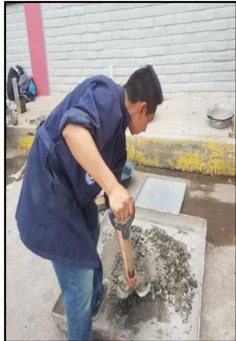
Fotografía 74. Mezclado de los materiales
