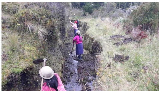
Imagen 31: Limpia de canales de agua de riego Fuente: Palacios, 2019
