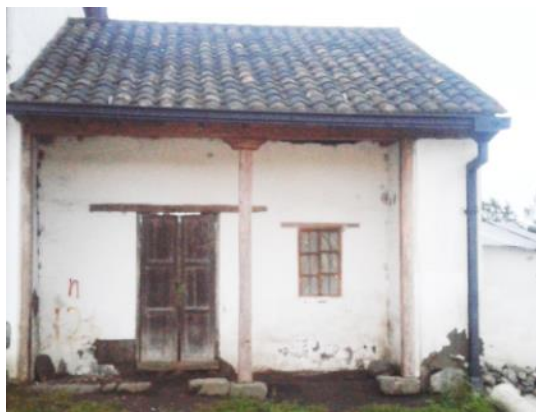
Imagen 46: Cubierta de Tejas Fuente: Fotografía de Iván Palacios
