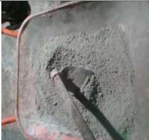
Mezclas los agregados con cementos
