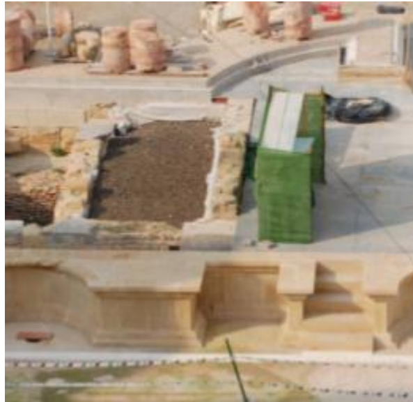
Figura 12. Empleo de Puzolana para protección de restos arqueológicos en las obras de restauración del Teatro Romano de Cartagena.
