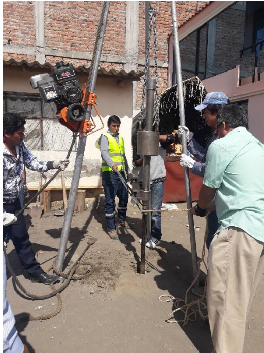
Fotografía 1. Hincado del Martinete
