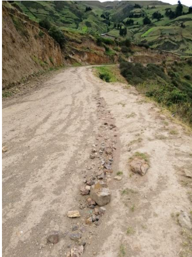
Levantamiento de la vía actual
