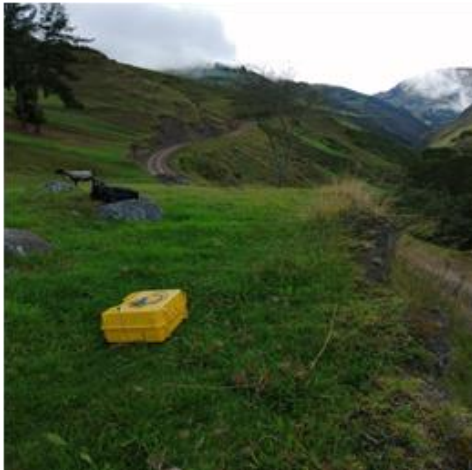
Estado de la vía actual tramo 1+100
