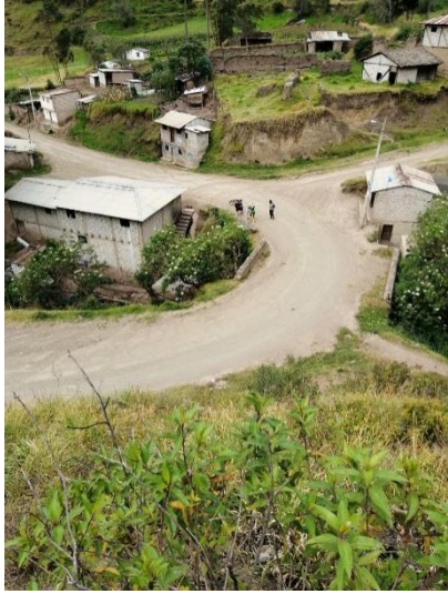
Levantamiento de la vía actual.
