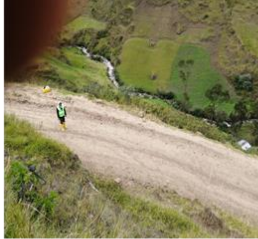
Levantamiento de la vía actual.
