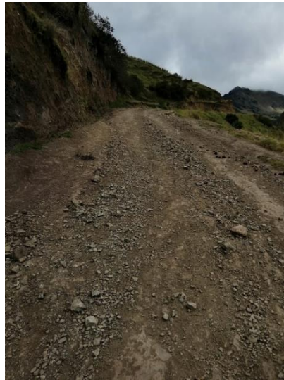
Levantamiento de la vía actual
