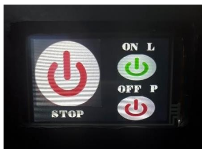
Figura 4.42 Encendido de las luces principales
