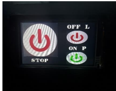
Figura 4.44 Encendido de paro de emergencia
