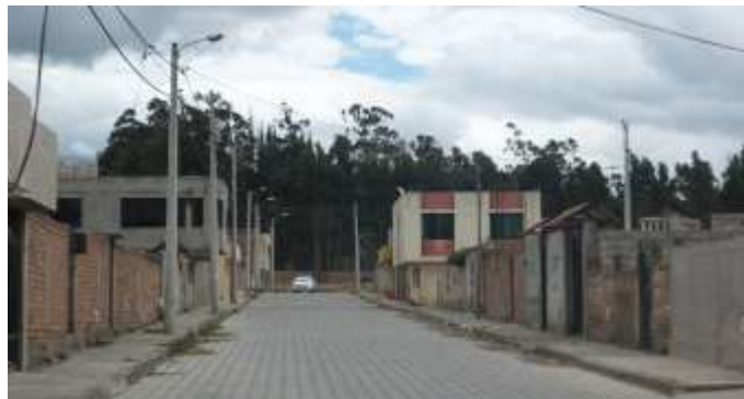
Gráfica 6-25. Edificaciones existentes de la urbanización “Tu nueva vida” a línea de fábrica, en la calle Arawacos. Fuente: El Autor, (2018).
