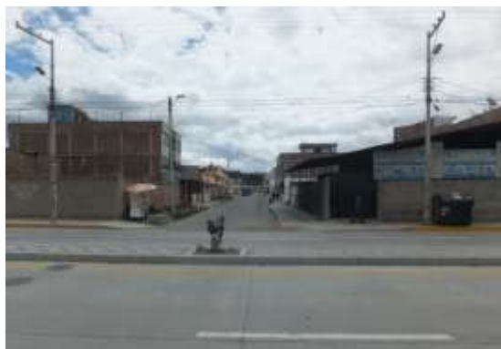
Gráfica 6-23. Acceso Sur-Norte por la calle Arawacos, desde la cooperativa de vivienda 24 de Mayo. Fuente: El Autor, (2018).
