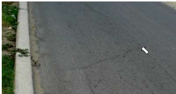
Figura 42: Grietas parabólicas
