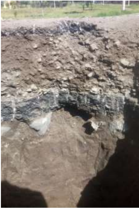
Estructura del pavimento
