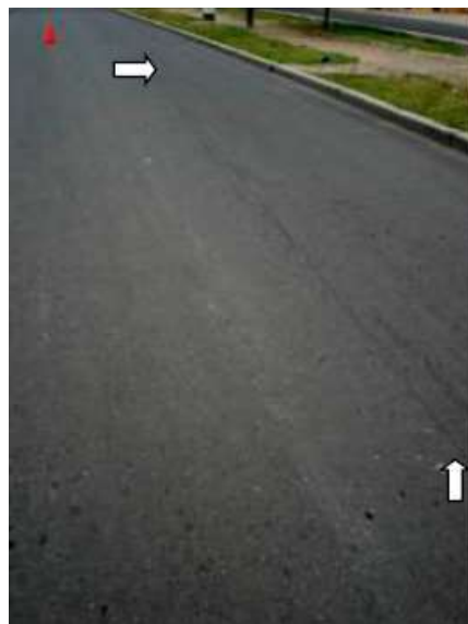
Figura 40: Ahuellamiento
