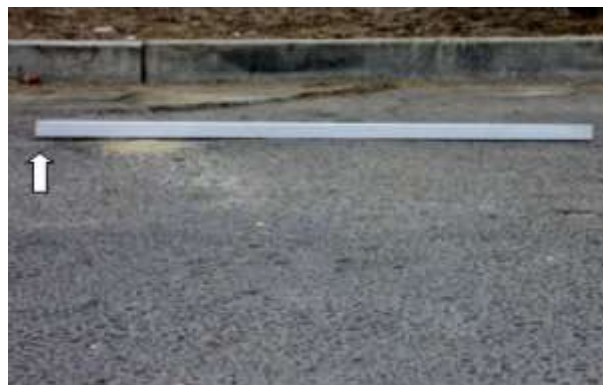
Figura 30: Abultamientos y hundimientos
