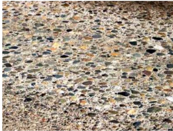
Figura 38: Pulimiento de agregados
