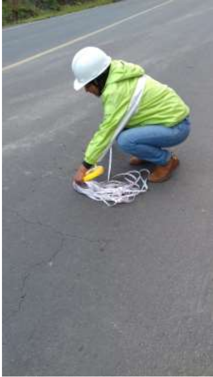
Registro de fallas en el pavimento
