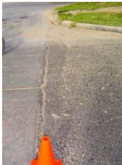
Figura 41: Desplazamiento
