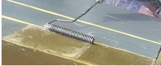
**Figura 3.11.** Material compuesto siendo pasado por el rodillo
