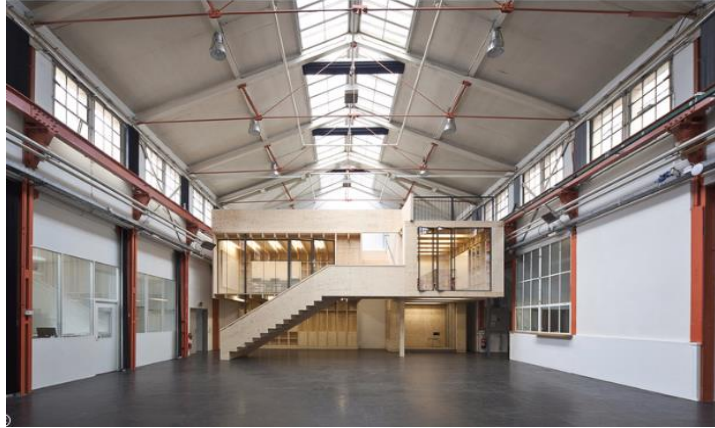
Imagen N.-22: Estructura de madera en Launchlabs
