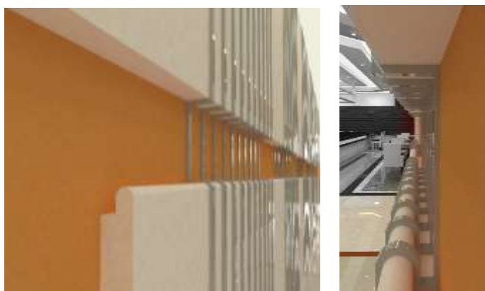
Gráfico 62. Detalle de pasamanos de pared con textura para circulación inclusiva. Detalles. Elaborado por: TIPANTUÑA, Freddy (2018)
