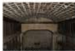
TECHO CURVO DE ESTRUCTURA DE MADERA
