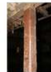
COLUMNAS DEL PALCO 1 PRIMER PISO
