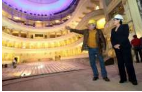
Gráfico 7-1: Interior del Teatro Municipal de Lima- Rehabilitado. Fuente: Agencia Andina, 2016
