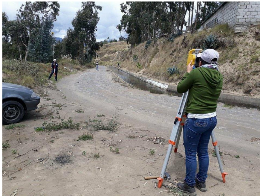
Enfocando los puntos de la vía junto al canal
