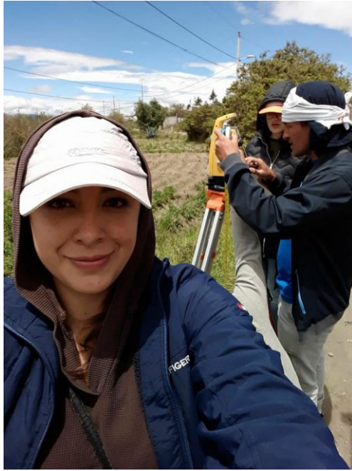
Colocando y encerando la Estación total
