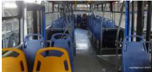
Figura 2. 21. Colocación del piso [21].
