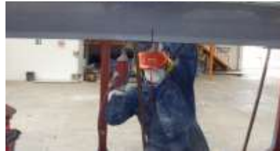
Figura 2. 21. Procedimiento de Forrado Interior de Techo [21].
