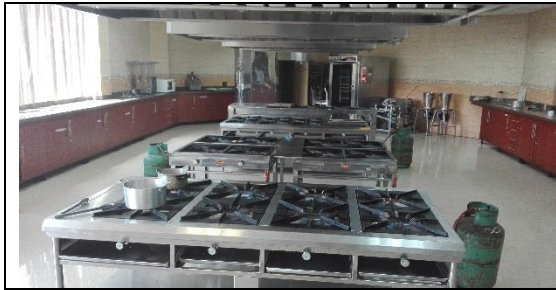
Aspectos de edificio gastronomía
