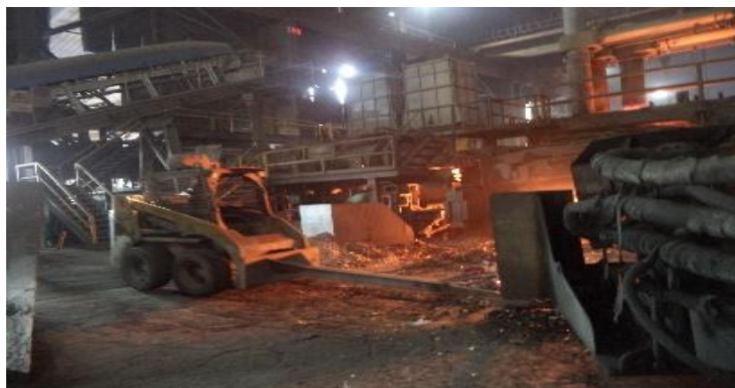
Gráfico 14. Horno de arco eléctrico, proceso de fundición del acero. Elaborado: Diego Javier Carrillo Abril
