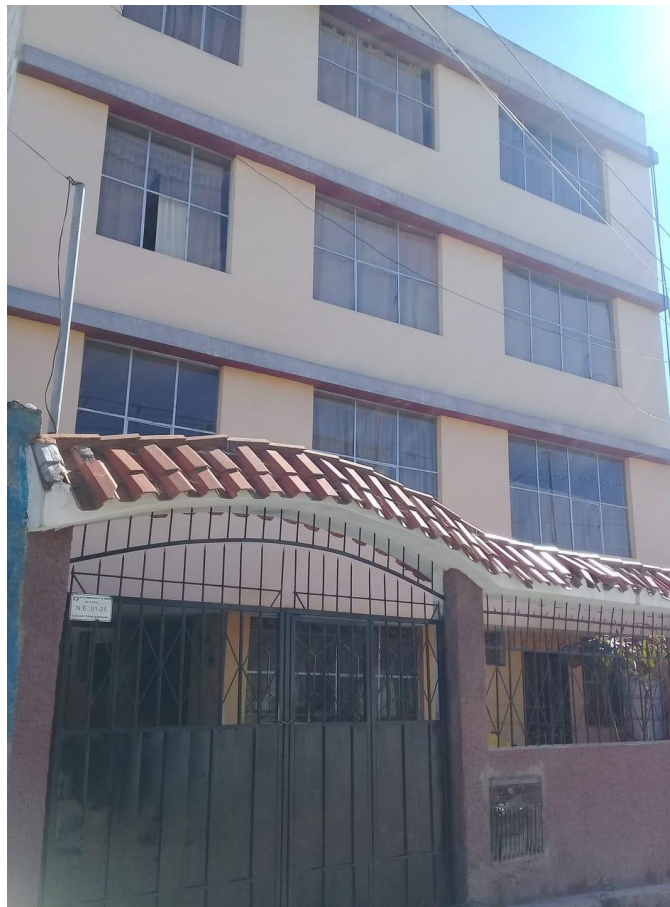
Fotografía 9. Estructura de 4 Pisos
