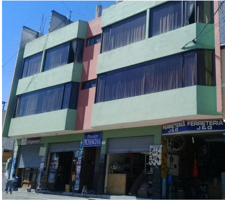
Fotografía 8. Estructura de 3 Pisos
