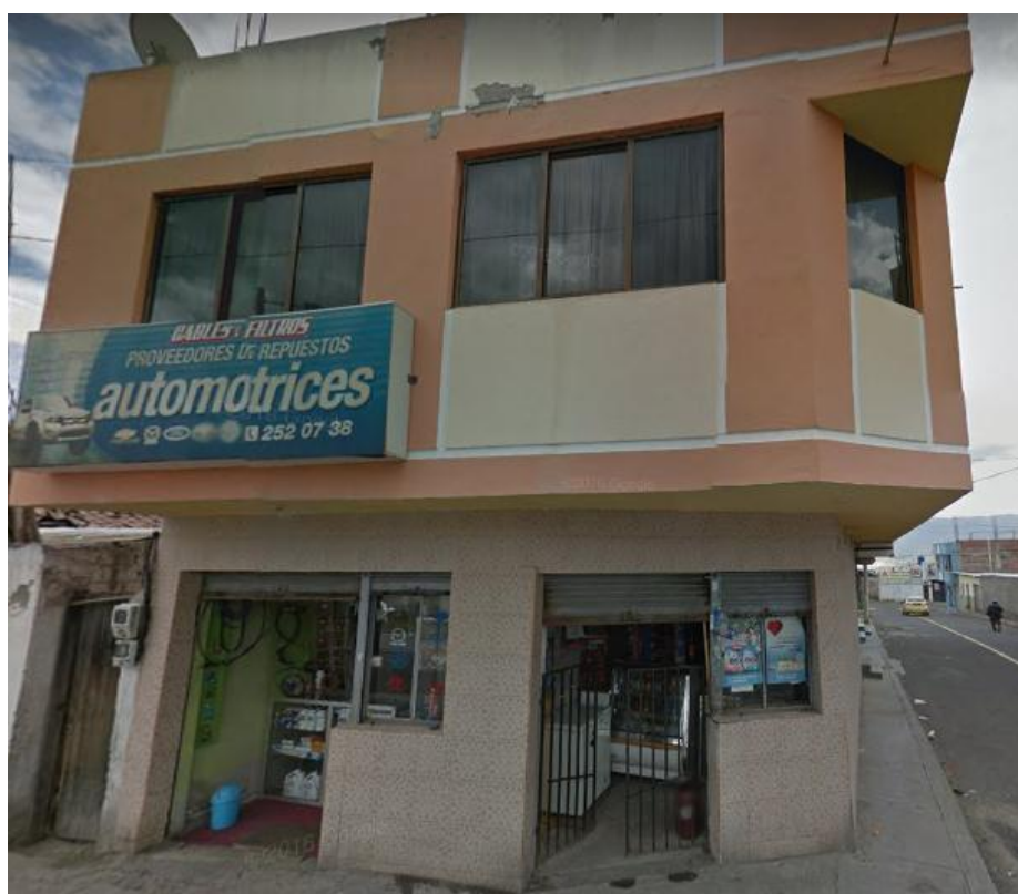
Fotografía 7. Estructura de 2 Pisos
