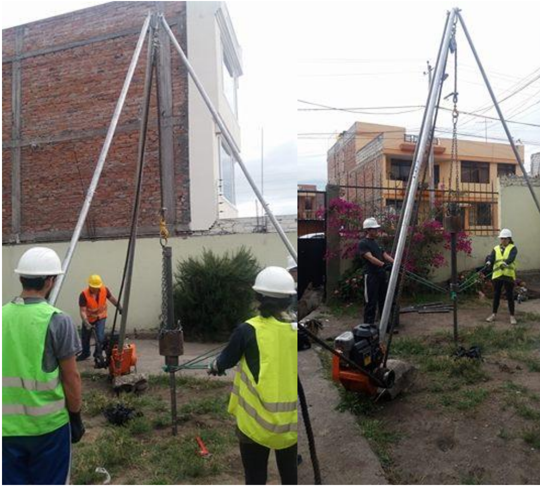
Fotografía 1. Realización del Ensayo de Penetración Estándar SPT
