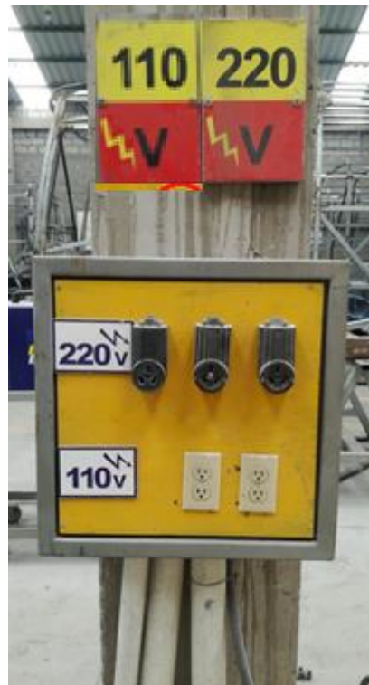
Figura 2. Circuito eléctrico con Protección
