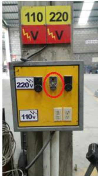
Figura 1. Circuito eléctrico sin Protección
