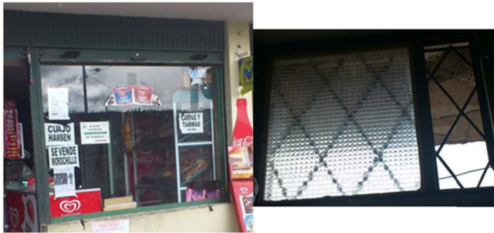
Figura 6.23 Ventanas del local comercial “Cabinas Israel”
