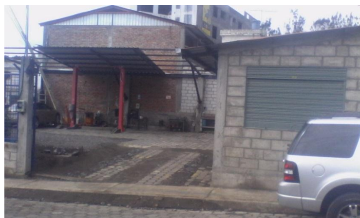
Figura 48: Imagen de la nueva instalación del taller AEOM 2017 Fuente: Taller AEOM
