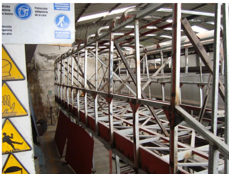
Figura 3 Construcción de estructura
