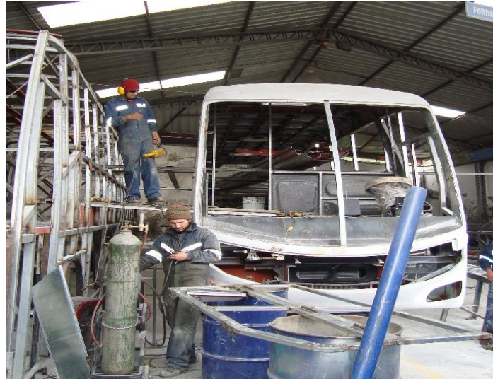
Figura 5 Armado y Acople frontal y posterior
