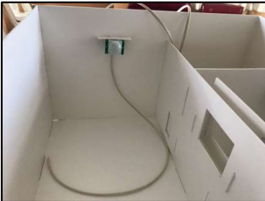
Figura 53. Instalación de Sensores en el Prototipo.
