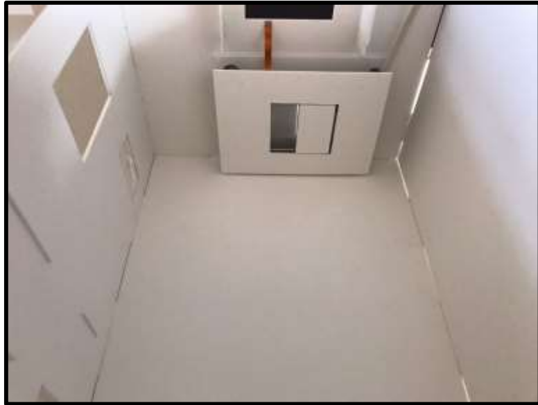
Figura 50. Instalación de Puertas en la vivienda.
